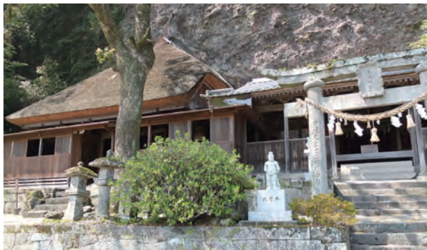
写真 44 天念寺講堂修理後の様子（平成22年）
