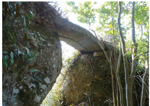
写真24 無動寺無明橋
