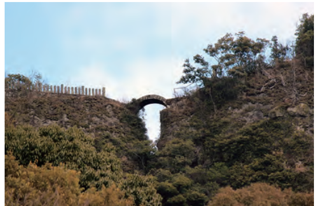
写真23 天念寺無明橋
