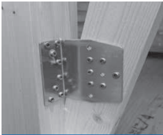
耐震補強(金物)
