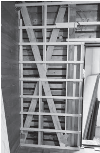
耐震補強(筋交い)
