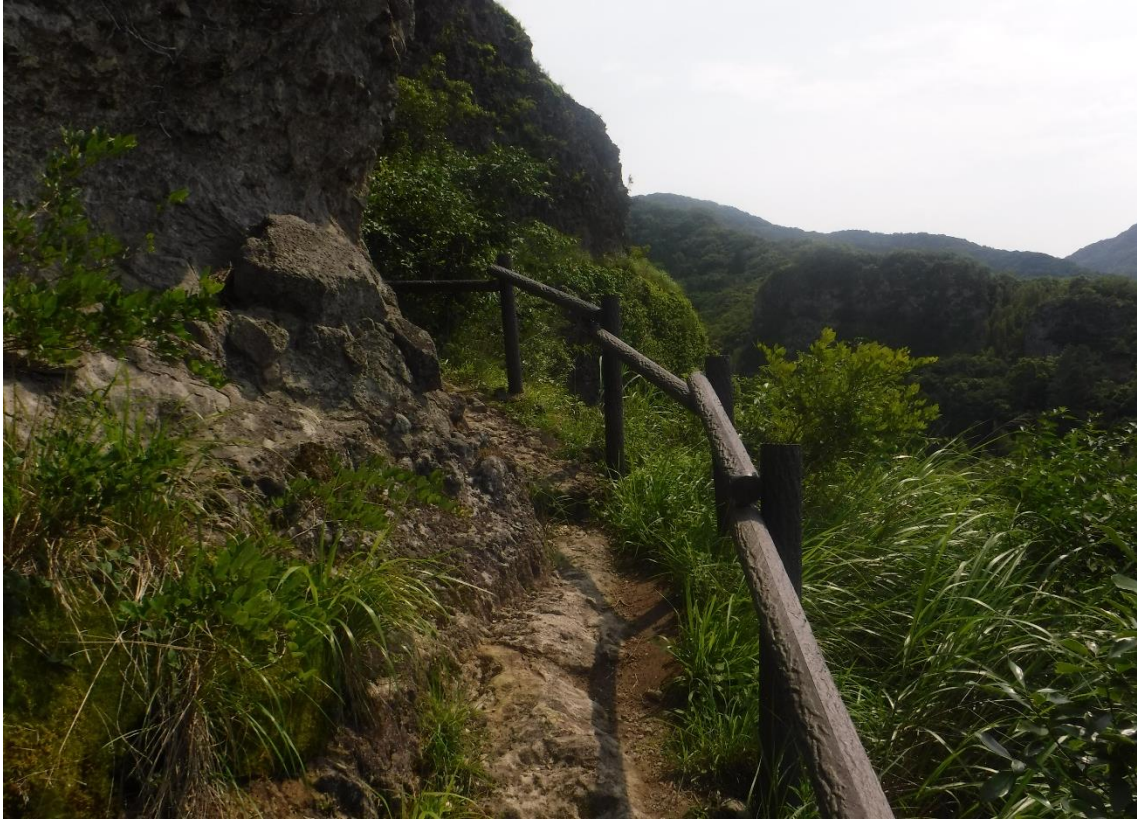
写真 10 : 峯道の手摺り設置状況
