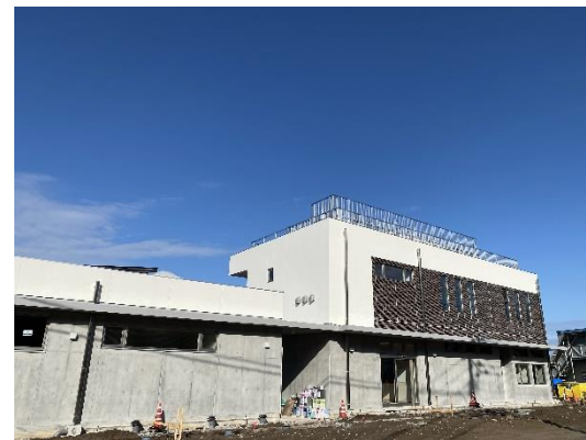
現在建設中の拠点施設
