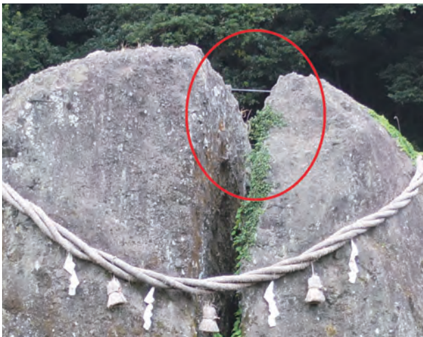
写真 45 兄弟割石のアンカーの様子
