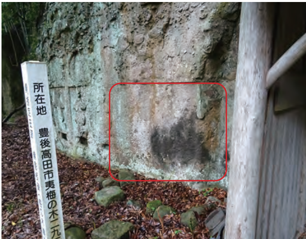
写真 39 磨崖連碑（赤枠）の摩耗状況
