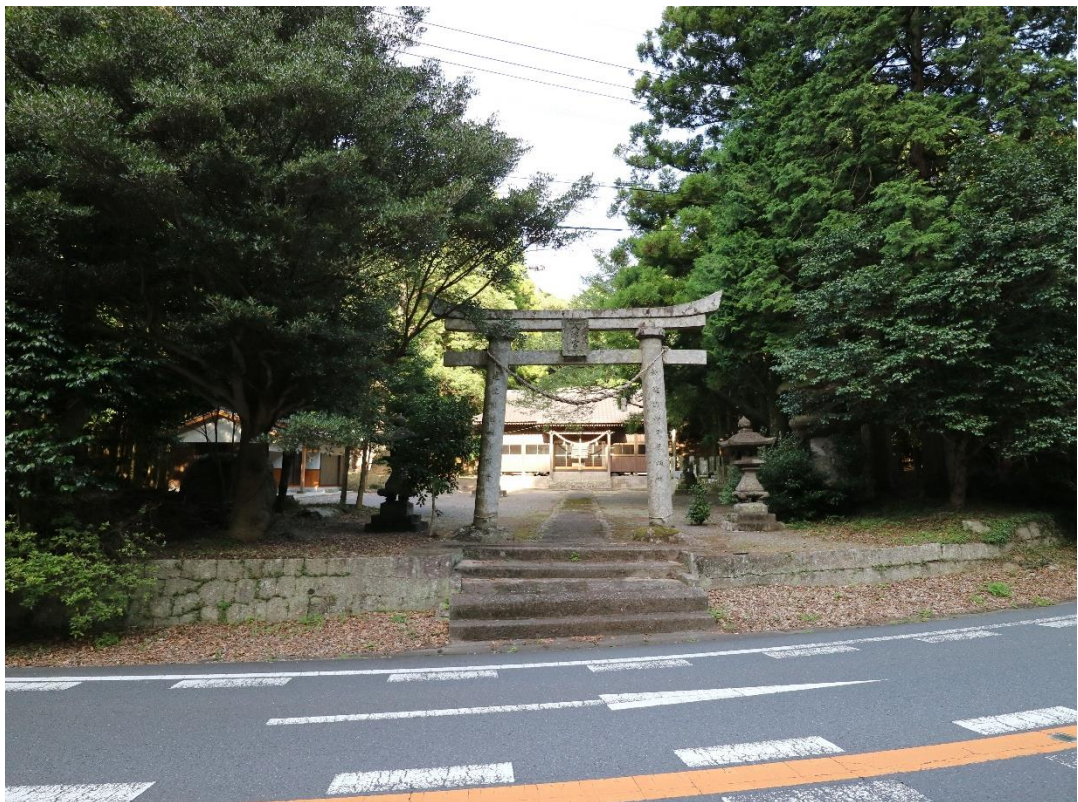
写真5：三宮八幡神社 遠景
