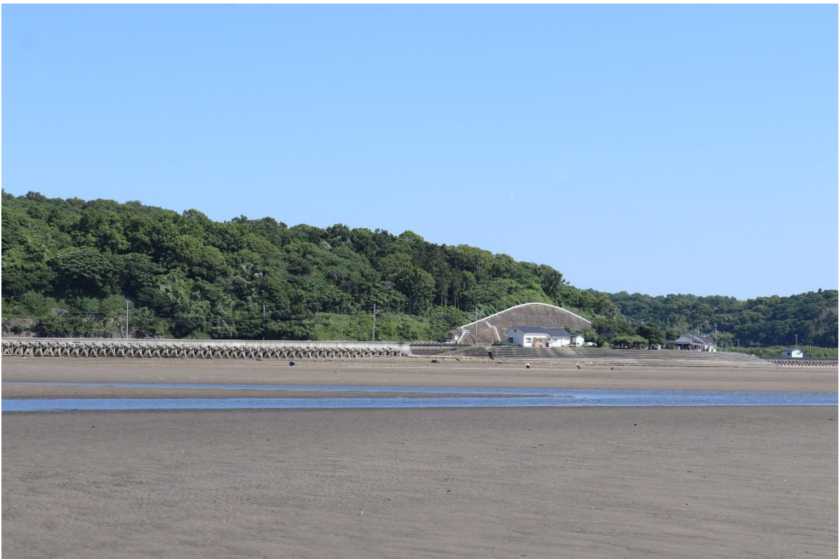
写真 18：消波ブロックの設置状況（北側・海側から）
