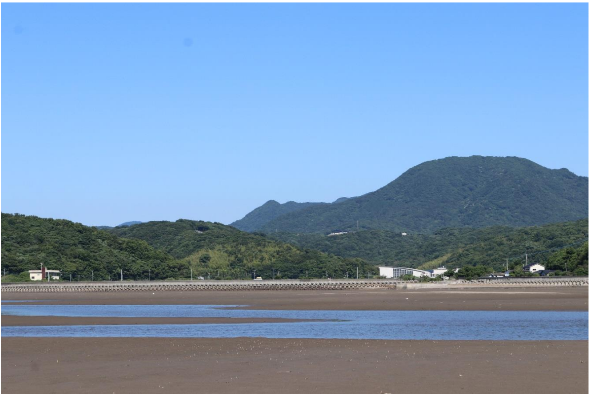
写真 16：消波ブロックの設置状況（南側・海側から）
