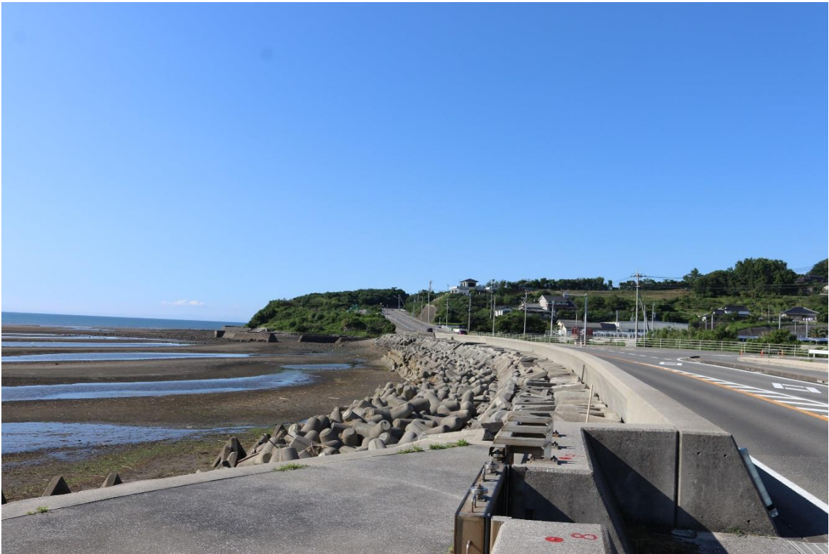
写真 17：消波ブロックの設置状況（北側・陸側から）
