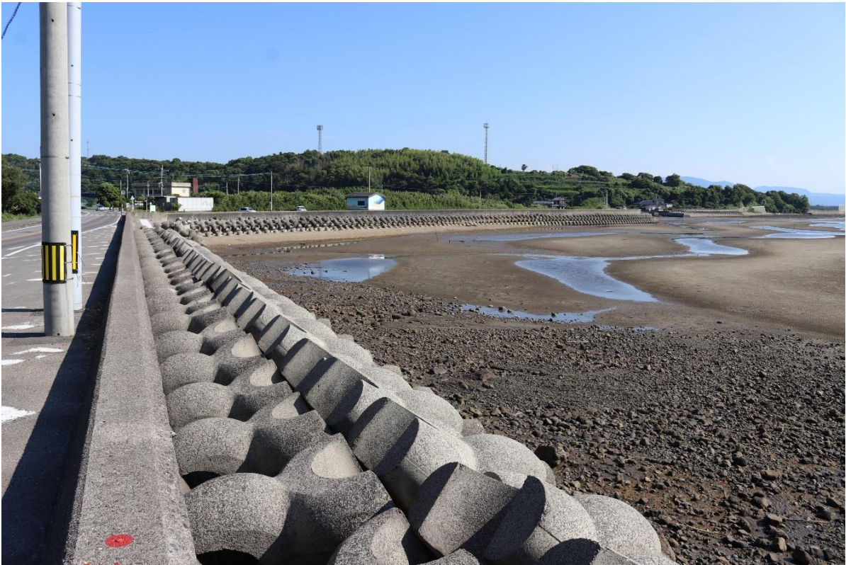
写真 15：消波ブロックの設置状況（南側・陸側から）
