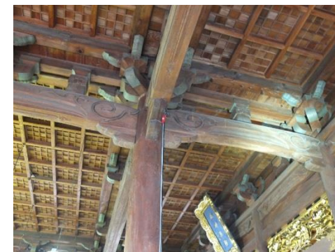
妙壽寺本堂 内部(格天井・虹梁など)
