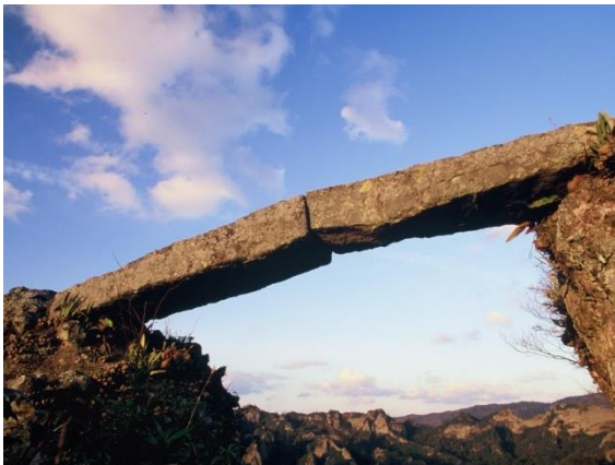
現況写真 11 無明橋
