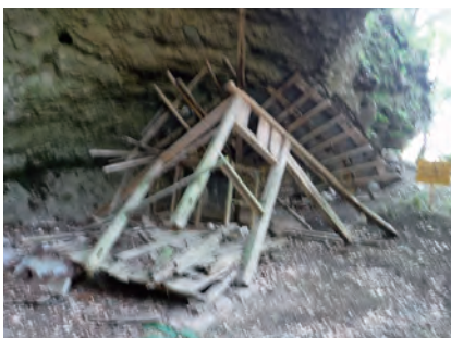
倒壊した茅場堂の状況
