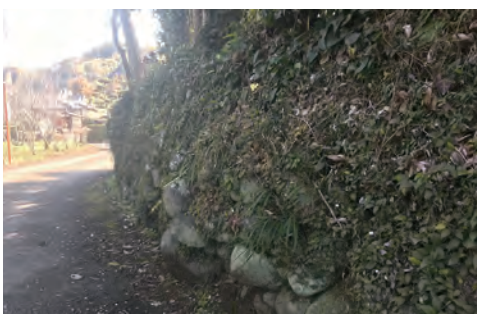
延寿寺北西土塁状遺構
