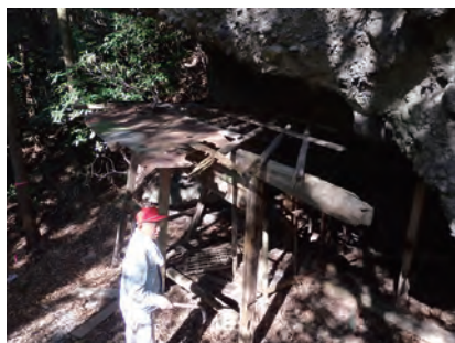
倒壊前の屋根の状況
