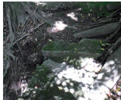
奥愛宕社参道の破損
