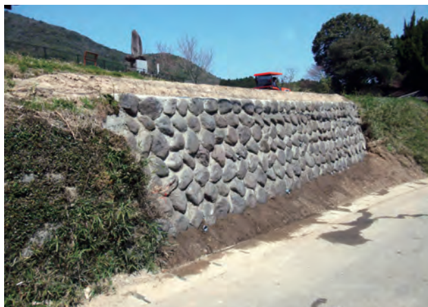
台風により毀損した水田の補修（平成26年度）
