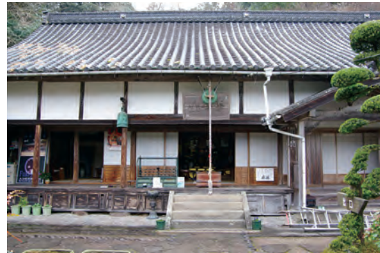
第14図 富貴寺本堂 正面外観
