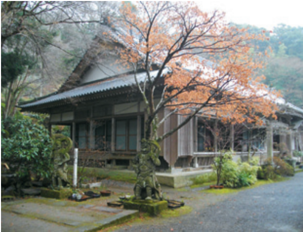
25:長安寺本堂・庫裡 図版②参照：U地点／時期：－
