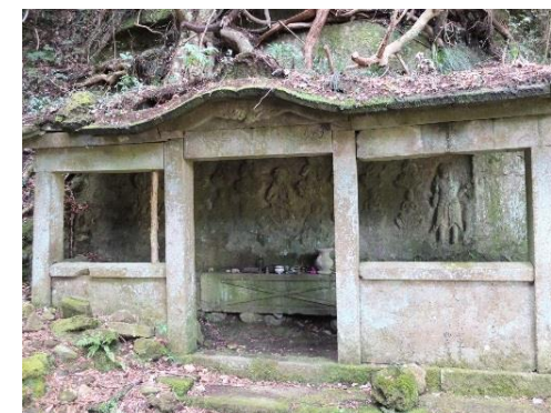
保存修理前の福真磨崖仏 石造覆屋
