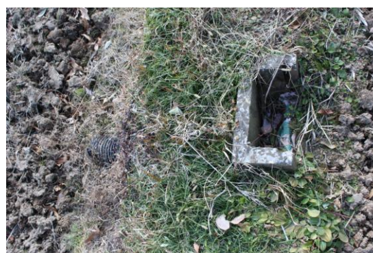
田越しかんがい施設（整備後）
