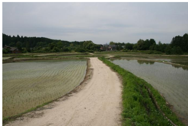
〈写真 1-5-4 拡張された農道〉
