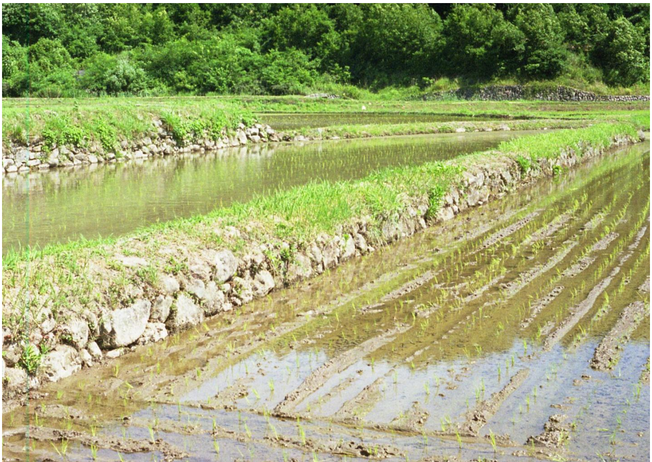
写真 1-3-3 扇状地礫による畦の擁壁
