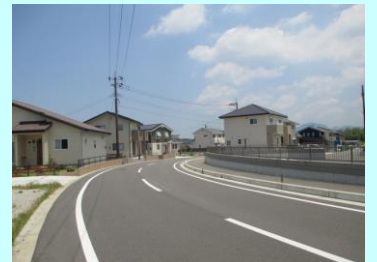
城台団地内道路整備事業(仮称)
