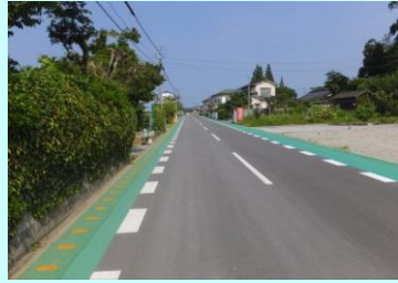
市道志手町新屋敷線改修事業
