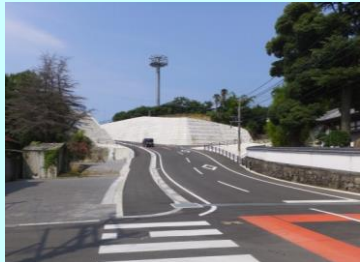
市道坂ノ上線改修事業
