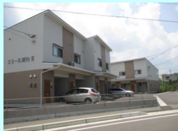
公営住宅整備事業
