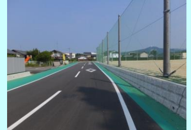
市道算所中学校線改修事業
