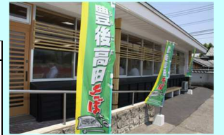
旧図書館活用整備(そば道場)
