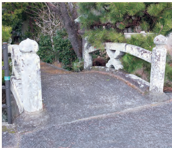
安養寺参道橋
