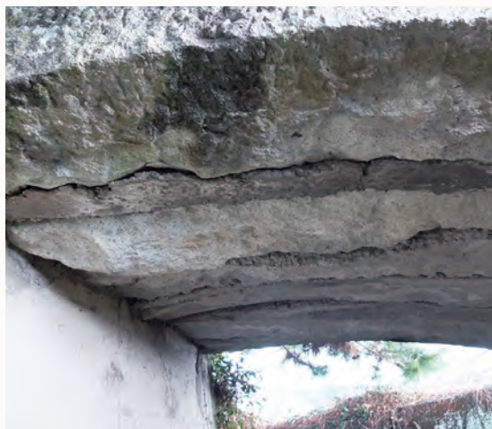
6本の桁石を架け渡している
