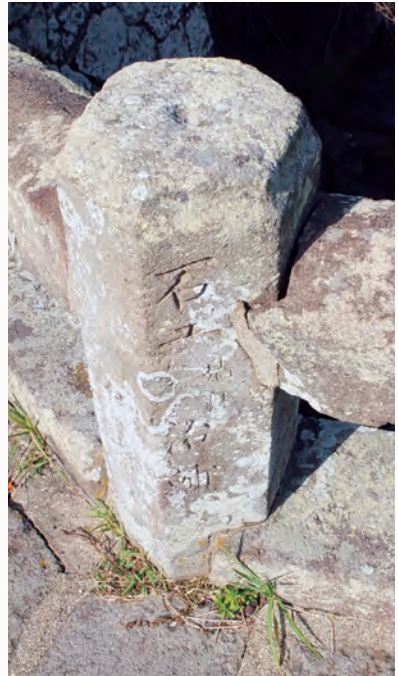
潮観橋親柱 六角形の親柱は、国東地方特有の形。側面には「石工 見目 治輔」の銘が入る。
