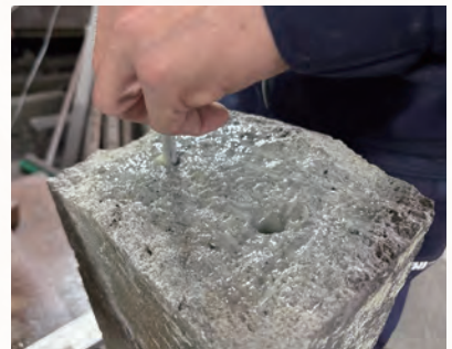
欄干の破断面にステンレスピンを挿入します
