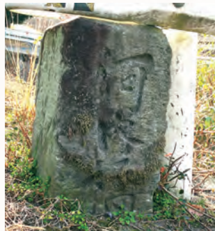
親柱に刻まれた「河内橋」の銘
