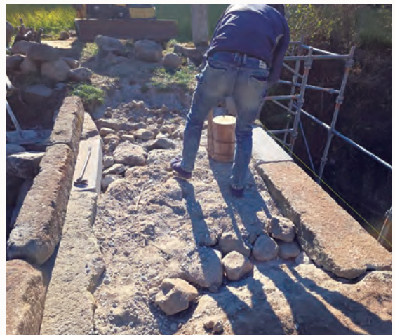
路面の転圧作業
