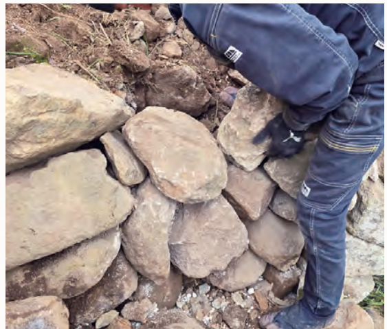
壁石の石積み作業
