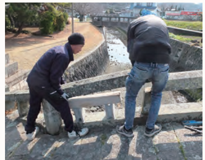
接合した欄干を元の場所に戻します
