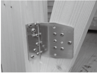
耐震改修（金物）
