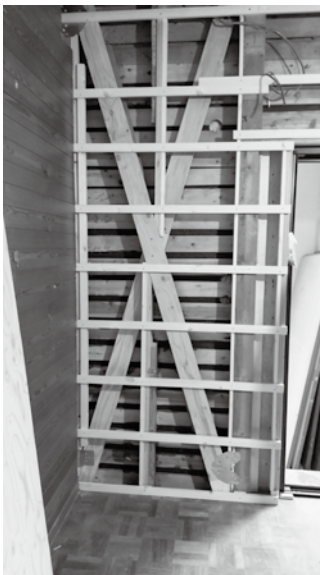
耐震改修（筋交い）
