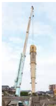
⑨ クレーンで設置する。
