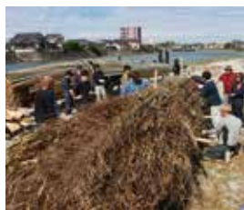
⑥ 中心に入れた竹に再度メダケ・孟宗竹を巻き、番線で固定する。
