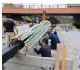
③支柱の周りに、②で割った孟宗竹を紐で結び付ける。
