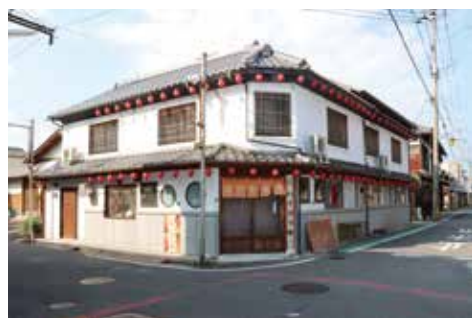
創業支援施設（中央通）
