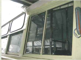
側面の引き違い窓・上げ下げ窓 傷みの激しかった下部等に新材の鉄板を補い、オリジナルどおりの形状に修復
