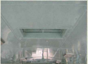
車体内面 車体内面の鉄板の合わせ目に「パイビン」と呼ばれるビニール製品を挟み込み、鉄板の小口を玉縁状に覆う
