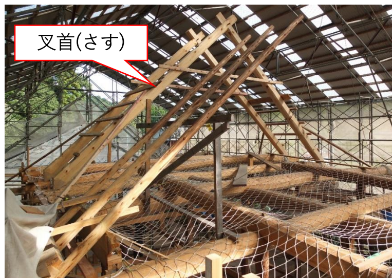
すやね 本堂を覆う「素屋根」の中で、組立作業が進められています。 （写真は10月9日現在の作業の様子）
